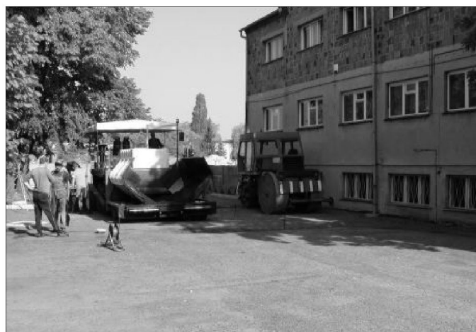
Pokrywanie nawierzchnią asfaltową parkingu przed Urzędem Gminy.
