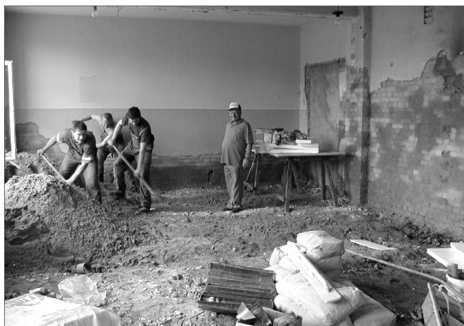
Prace remontowe w Magdalenkach trwają.
