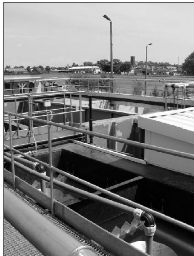
Oczyszczalnia ścieków w Pępowie w trakcie modernizacji.
